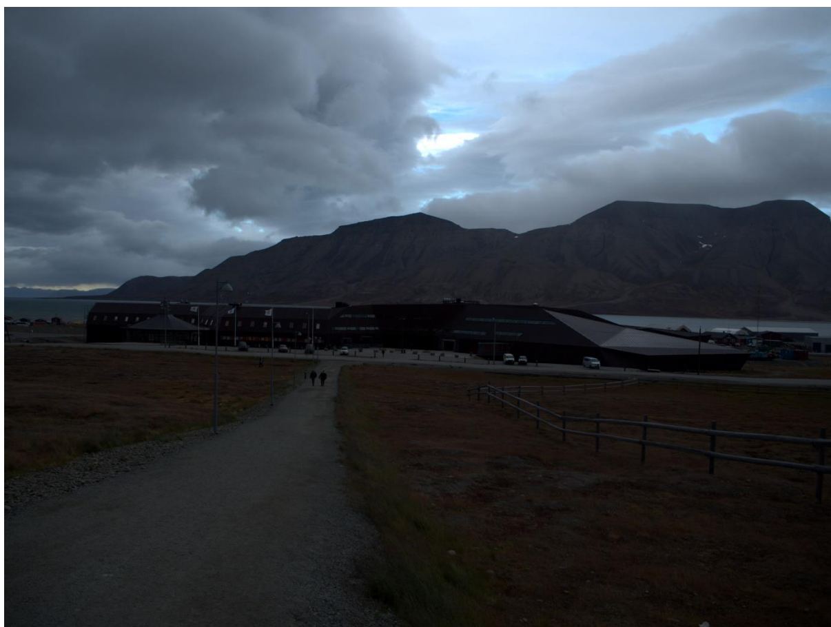
Fot. 1 Budynek UNISu w dniu 12.09.2017
