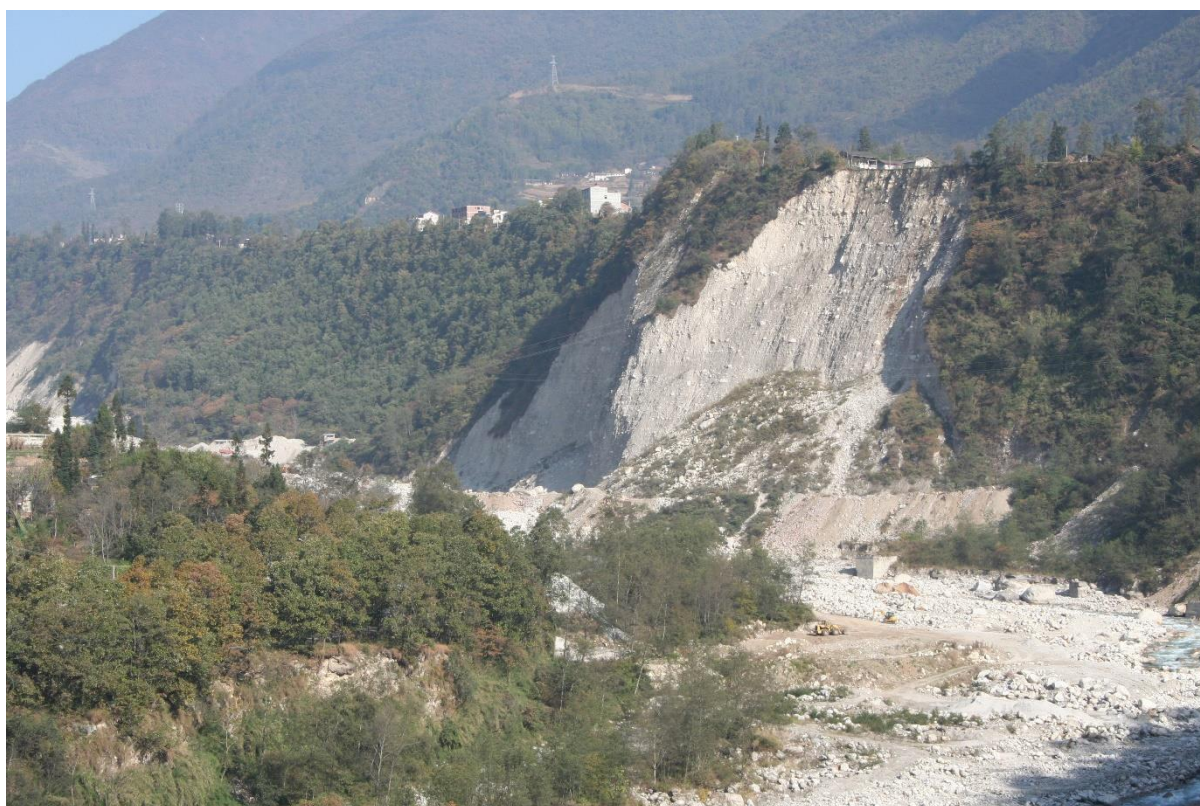
Osuwiska i obrywy wysokości 100 m w luźnym materiale osadowym (holoceńskie osady spływów gruzowych i osady wodnolodowcowe) wypełniającym dno doliny głównej w zlewni Moxi.
