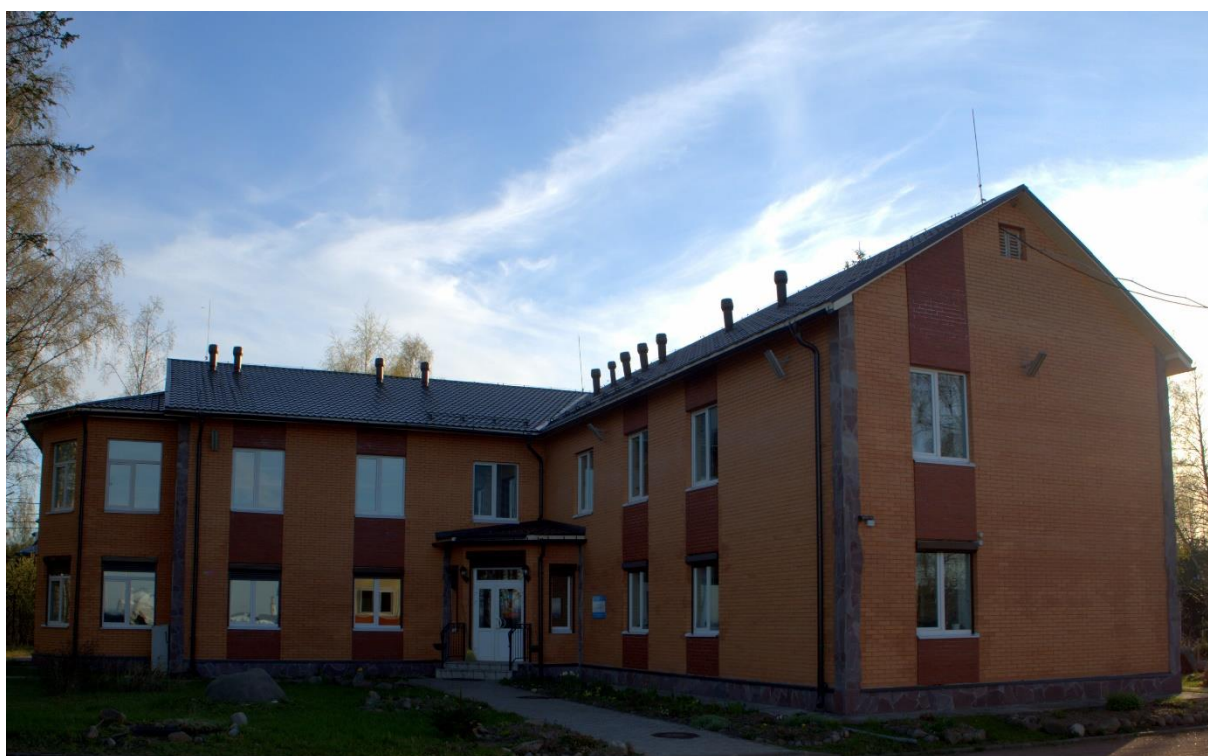
Fot. 3 Budynek bazy terenowej AARI „Ładoga”.
